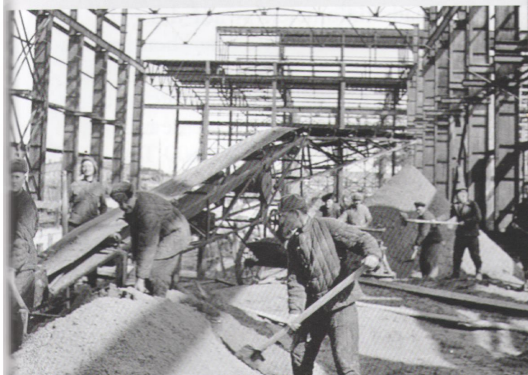
Arbeiter beim Bau des Minsker Traktorenwerkes (MTS), 1947. Foto: BelTA
