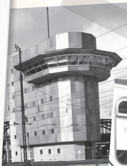
Aufbruch in eine neue Zeit: 1964 geht das Relaisstellwerk München in Betrieb.
