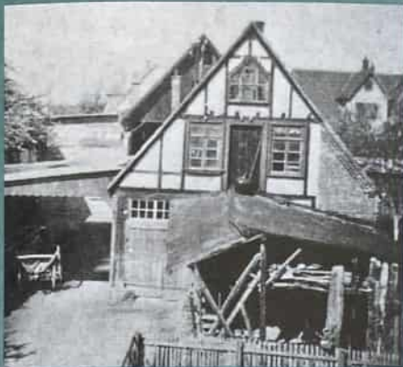
Die Werkstatt in Möhringen 1928. Alle Auwärter-Söhne erlernten das Wagnerhandwerk und arbeiteten als Gesellen im Betrieb. Der Plattformwagen rechts unten wurde 1954 von Martin Auwärter als Gesellenstück gebaut.
