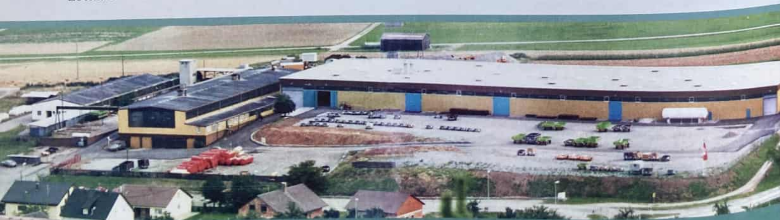
Das Werk in Simmozheim nach dem Bau der neuen Montagehalle 1980
